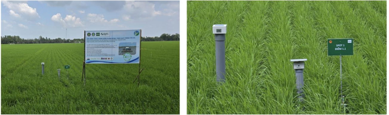
Hình 3.2: Trạm quan trắc mực nước IoT lắp đặt tại HTX Thuận Lợi
